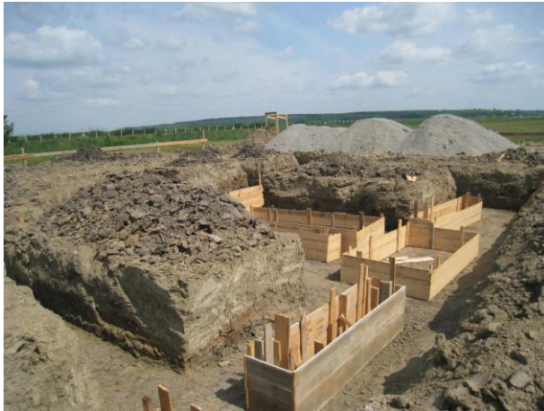
Pavilion de informare și monitorizare
